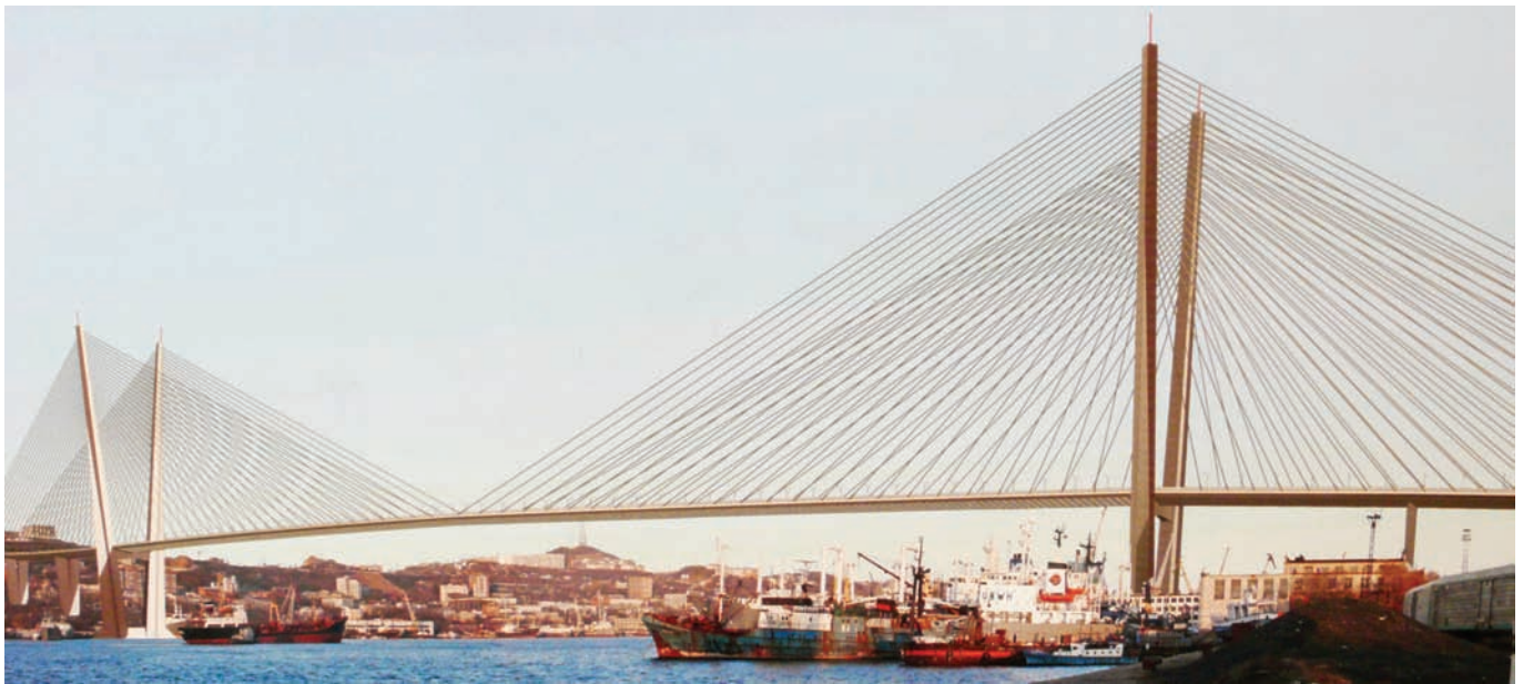
Projet de construction du pont de la Corne d'Or
